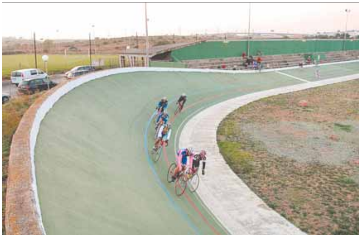
Varios ciclistas, entrenando ya con la pista repintada y reparada. FOTO: PERE FERRÉ
