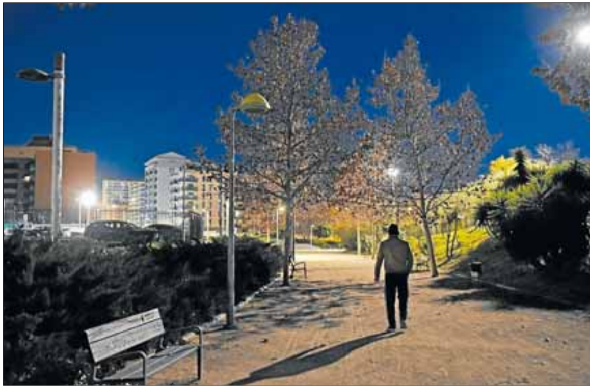
El Parc del Francolí está muchas horas a oscuras por culpa del robo de cable del alumbrado. FOTO: ALFREDO GONZÁLEZ
