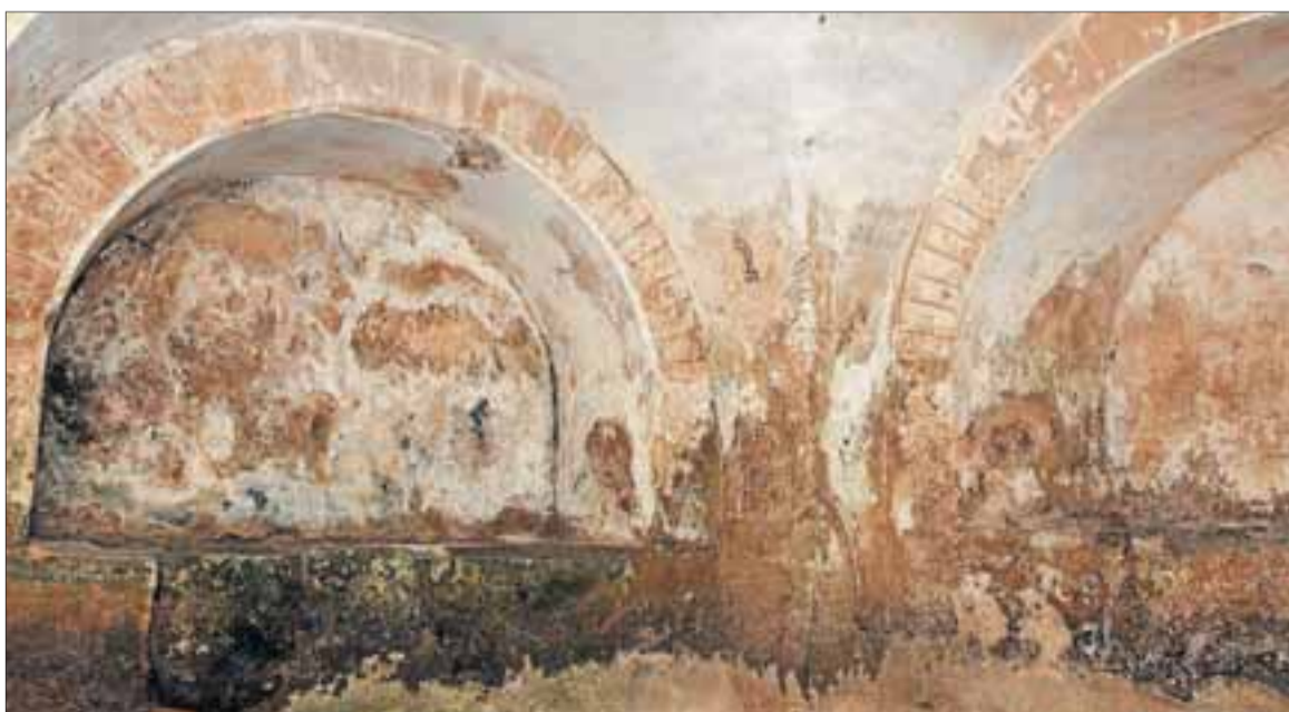
Interior de la cripta que se abrirá al público este año. Las manchas de humedad son evidentes. FOTO: CEDIDA
