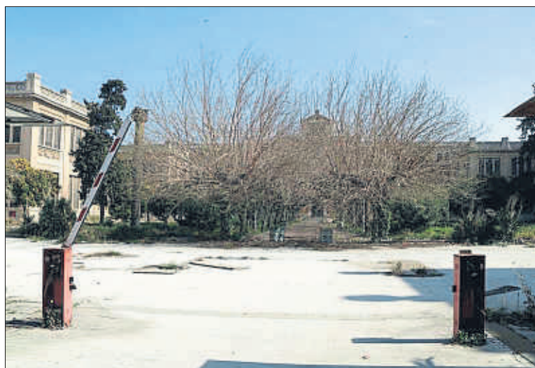
Aspecte actual de l'entrada de la fàbrica, que es convertirà en plaça
