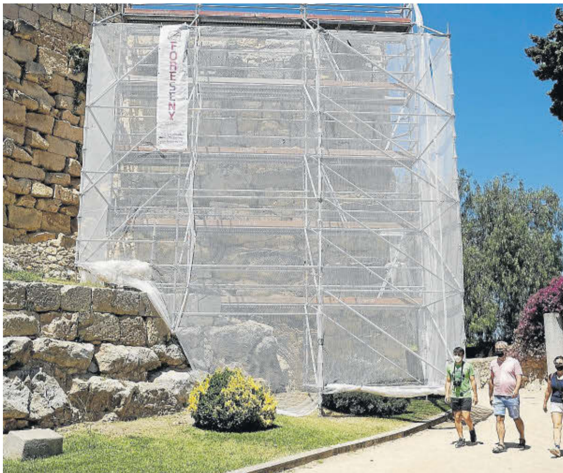
En la Torre de Minerva, con el andamio colocado, los operarios agujerearon la muralla. FOTO: FABIÁN ACIDRES/DT
