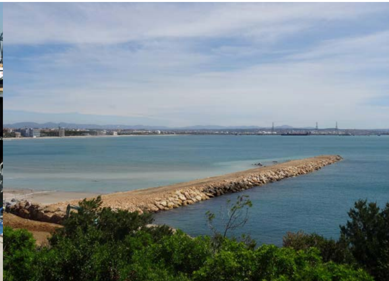
Obras de recuperación del espigón del Racó después del temporal Glòria Work on the El Racó breakwater to repair the damage caused by Storm Glòria
