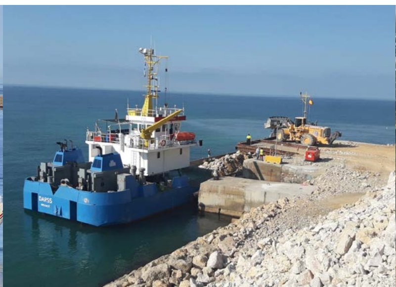
Carga de materiales de la cantera de Vallcarca (Garraf) para el nuevo muelle de Balears Loading material from the Vallcarca quarry (Garraf) to build the new Balears Wharf
