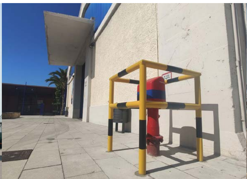
Despliegue de una red con 125 hidrantes para mejorar el sistema contra incendios Deployment of a network with 125 hydrants to improve the fire prevention system
