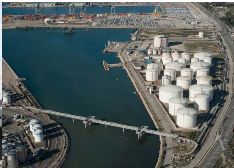
Nueva red contra incendios en la zona de Hidrocarburos New fire prevention network in the Hydrocarbons Zone
