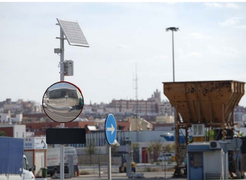
Instalación de las primeras señales de cruce inteligente en el recinto portuario Installation of the first intelligent intersection signals in the port zone
