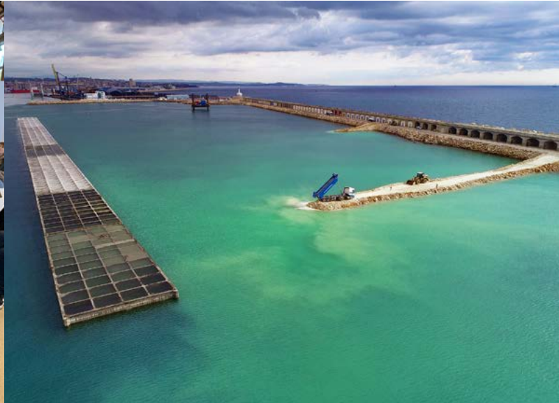
El muelle de Balears entra en una nueva fase con la construcción del dique sur y norte The Balears Wharf enters a new phase with the construction of the southern and northern breakwaters
