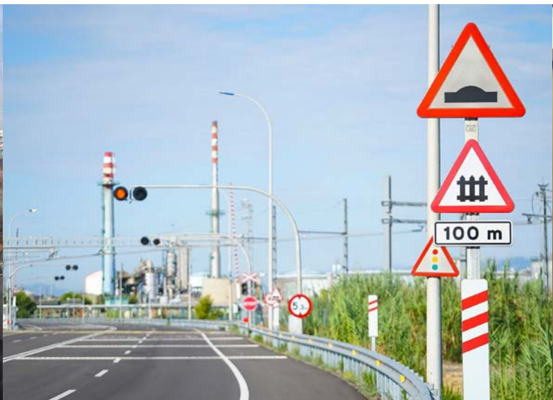
Mejora de la señalización viaria y ferroviaria con nuevos indicadores Improvement of the road and rail signalling with new indicators
