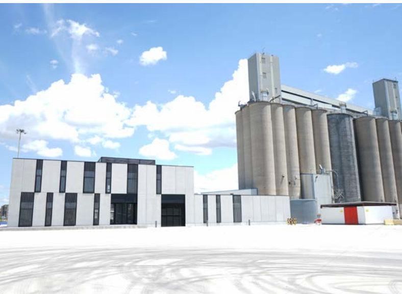
Nuevo centro de formación en el muelle de La Rioja New staff training centre on the La Rioja Wharf
